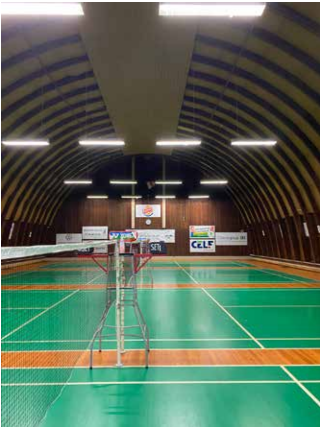
Kig igennem rundbuehallen, som fremstår i stort set original stand. En fantastisk halt at spille badminton i - men som trænger til renovering
